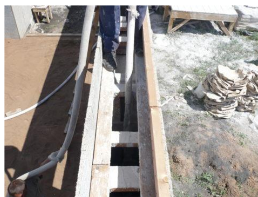
Рис. 5. Процесс заливки пеногипсовой смеси в конструкцию стен
