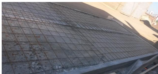
Рис.8. Изготовление опытной плиты перекрытия на основе ЛСТК и пеногипса на производственной базе «УГК»
