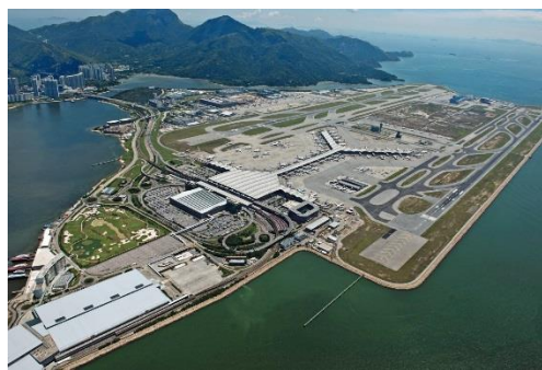
б) аэропорт Чеклапкок, Сянган, Гонконг (Источник: http://nemu.win/arsip/hong-kong-international-airport )
