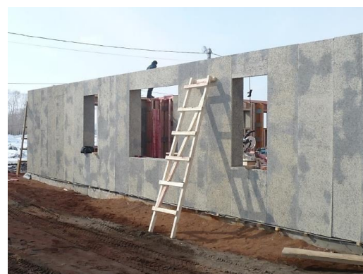
Рис. 6. Каркас будущего дома
