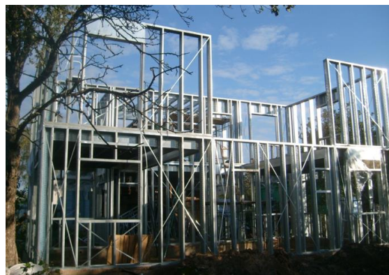
Рис.1. Монтаж ЛСТК при возведении здания
