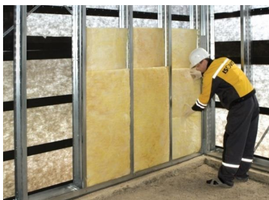
Рис. 2. Конструкция ЛСТК с применением минеральной ваты
