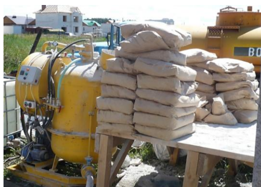
Рис. 4. Эжекторно-турбулентная установка на строительной площадке
